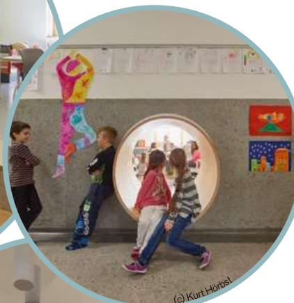
Eine mit einem Kernbohrer erzeugte Öffnung ermöglicht gemütliches Sitzen in einer Nische und Blickbeziehungen.
